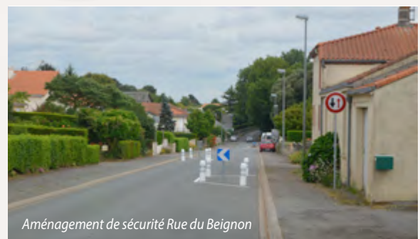
Aménagement de sécurité Rue du Commandant Guilbaud
