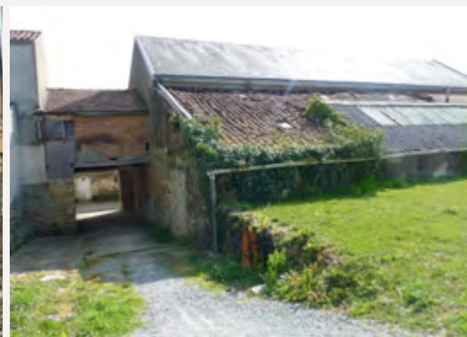
l'Atelier avant-travaux façade ouest
