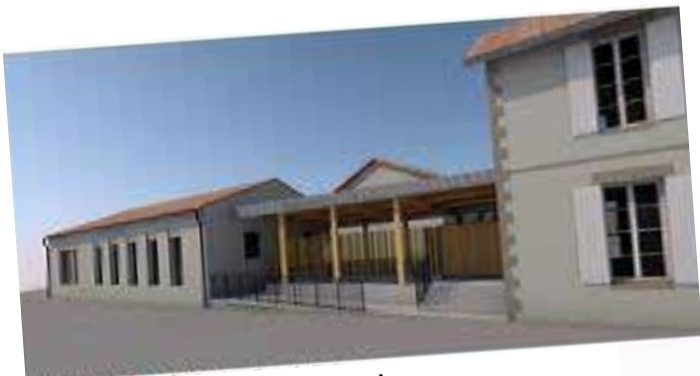
Vue sur l'accès principal - Rue du Beignon
